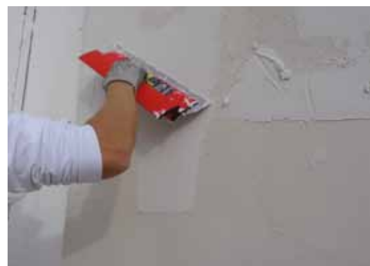
Pose de l'armature
