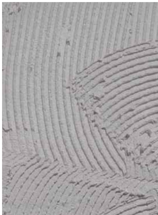
Application d'une couche de JEF COTHERM POWDER
