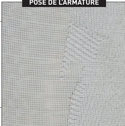
POSE DE L'ARMATURE
