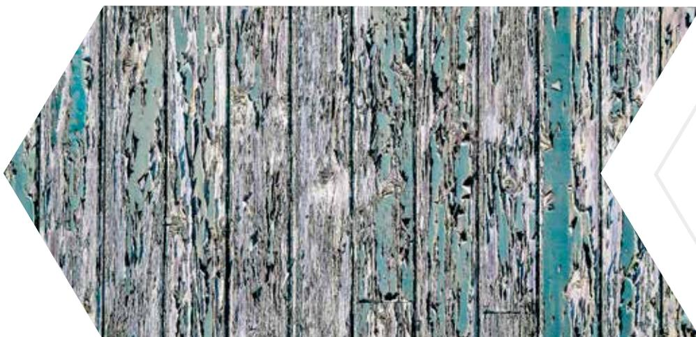
**TRAITEMENT** : Remise à nu du support par ponçage. Protection du support par un système impression + finition.
